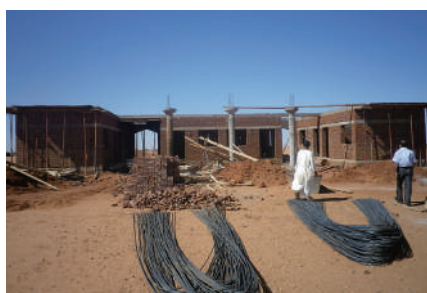
▲診療所建設中のようす。レンガを積み上げて診療所を造ります
