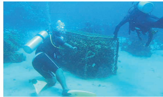
▲コンク貝を使用した小規模な人工魚礁の設置を支援しました。これなら、漁業者自身による作成、海底への設置が容易に行えます。
